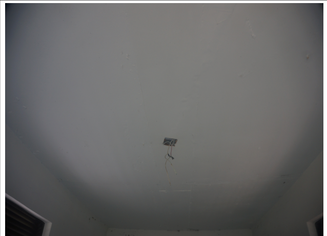
검수실 내부 보수 완료 현황
