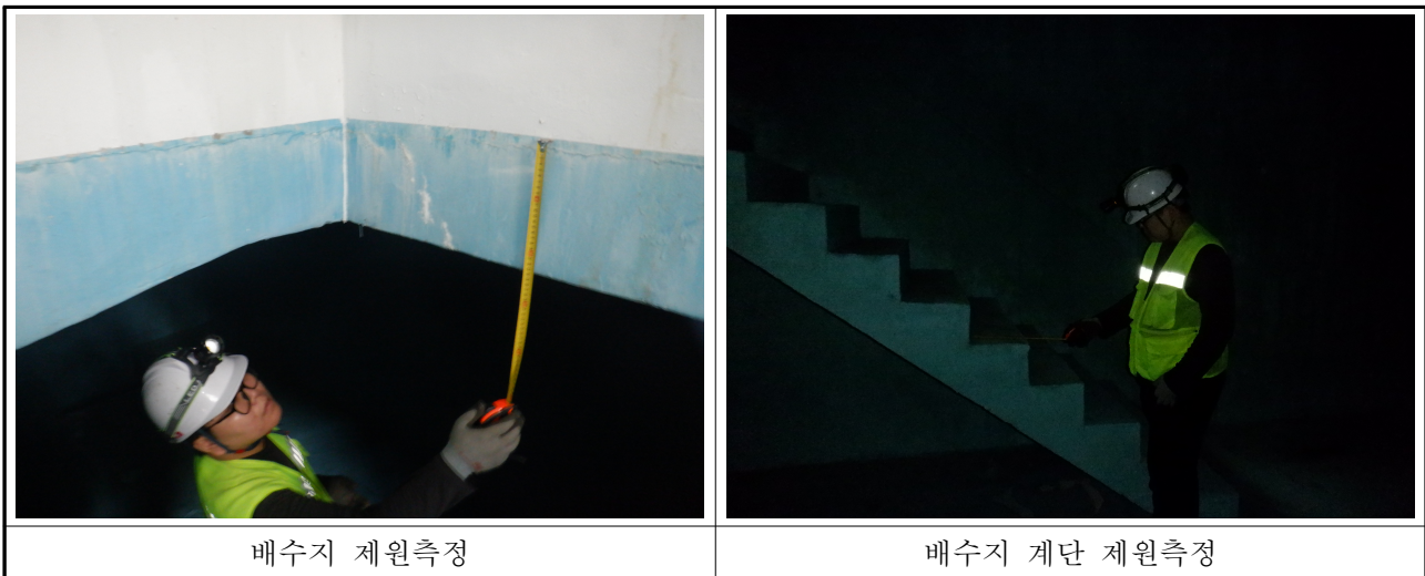
【사진 3.1】 시설물 외관조사
