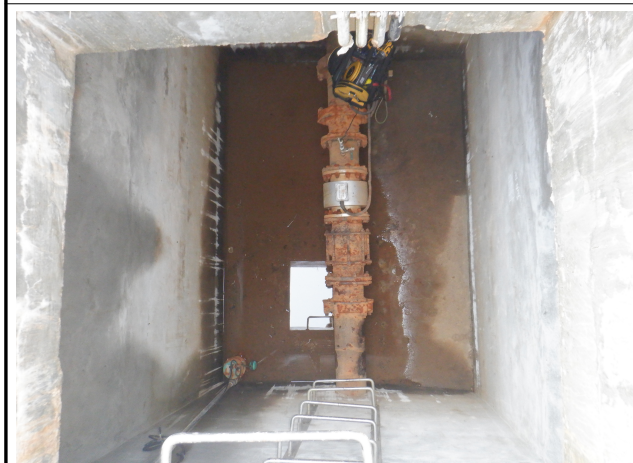
유량계실 바닥슬래브 채수
