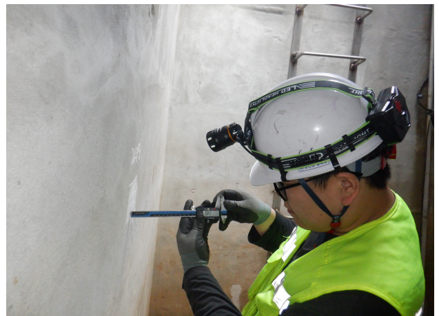
탄산화 깊이 측정
