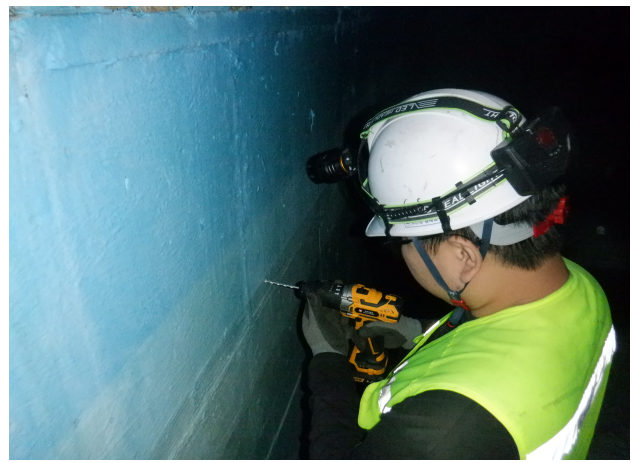
탄산화 깊이 측정
